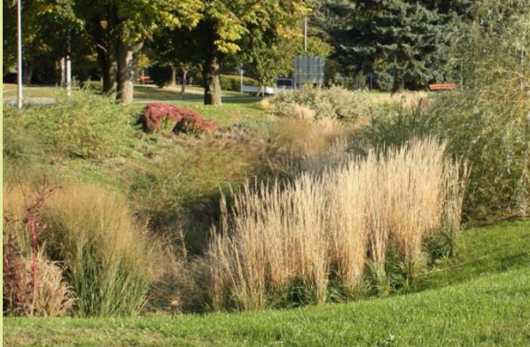
SUDS rendszerű csapadékvíz kezelés Zalakaroson, városi közparkban (Forrás: Csuka Veronika)
